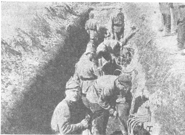
Установка баллонов с газами в окопах
